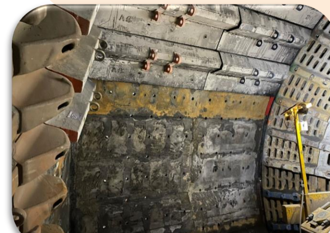
Sobre esfuerzos, trabajo en altura
